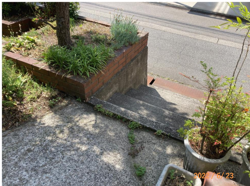
■現状写真■ (工事施工前)
