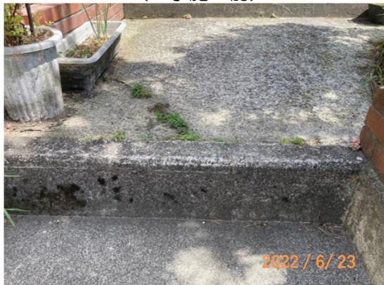
■現状写真■ (工事施工前)
