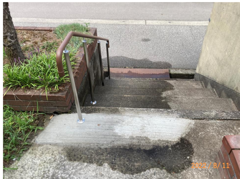
■施工後■ 手すり設置後
