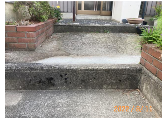
■施工後■ 手すり設置前
